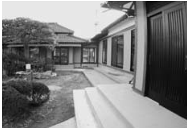
母屋と離れを廊下でつなぎ、一軒の「我が家」に
