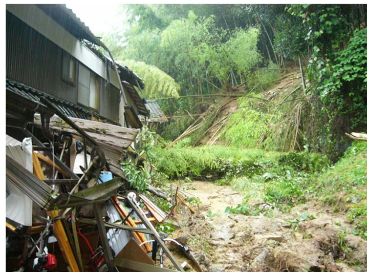
広島県廿日市で発生した 崖崩れ 2013年6月
