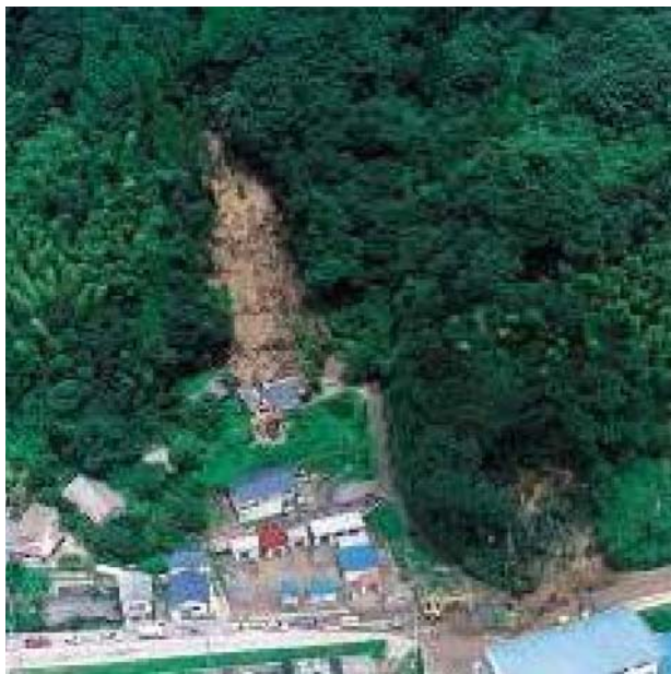
がけ崩れ (急傾斜地の崩壊)
