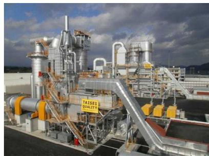
焼却炉は、火格子と呼ばれる鉄製の床の上でゴミを燃焼することで完全燃焼し、灰中の未燃分が少ないことから主に木くずを焼却する『ストーカ炉』と、回転する円筒の中でゴミを燃焼させることでプラスチックや土砂の付着した廃棄物も安定した焼却が可能となる『ロータリーキルン炉』の2種類が設置されました。
