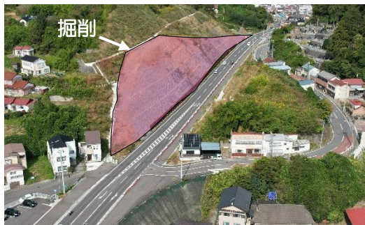
空撮写真 (本町橋側より撮影)
