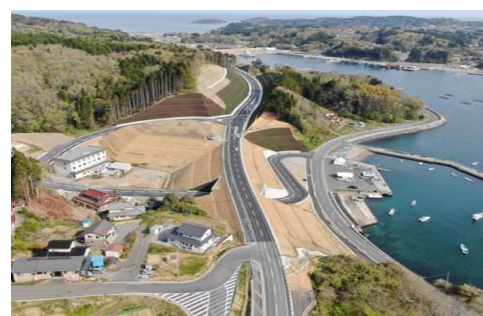
磯草工区 完成状況
