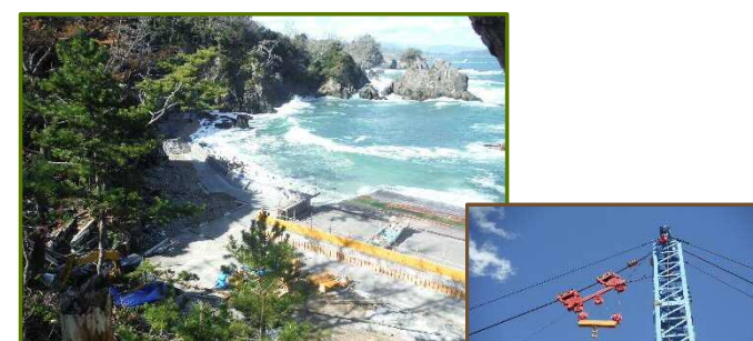
船尻地区：狭隘かつ急峻な地形 ケーブルクレーン本体
