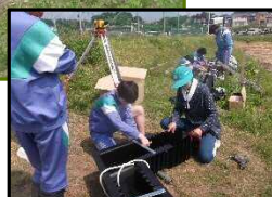
組み立て作業の様子
