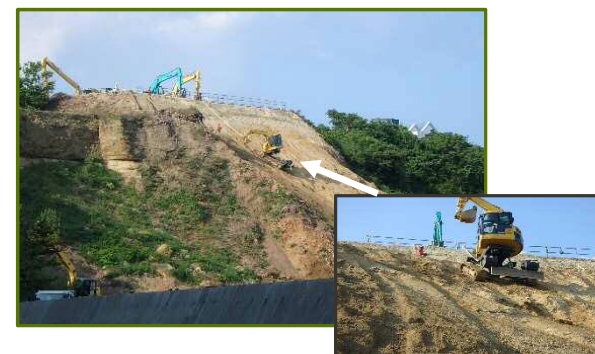
登米沢地区：高所法面掘削機による切土施工
