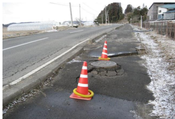
周囲の地盤沈下により、隆起したマンホール (迫川流域左岸幹線)
