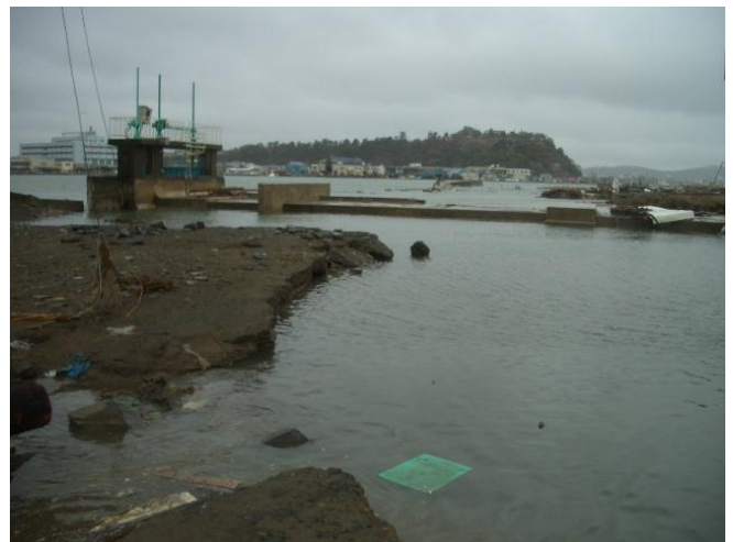
石巻東部浄化センター 放流ゲート前
