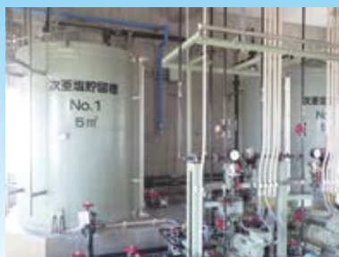
じあえんそさんちよちくそう ▲ 次亜塩素酸貯蓄槽
