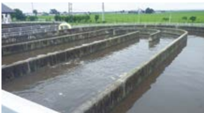
▲ オキシレーションディッチ
