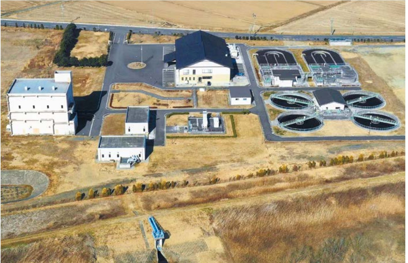
石越浄化センター全景
