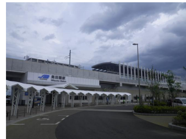
▲ 7/23 からの暫定運行再開に向けて々と復旧工事が進む美田園駅(6/24撮影)
