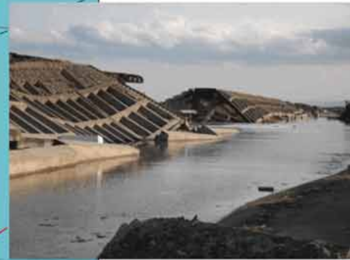
岩沼市二の倉海岸の被害状況
