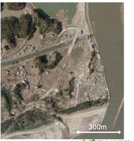
被災後（平成23年3月12日撮影）
