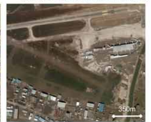
被災後（平成23年3月13日撮影）
