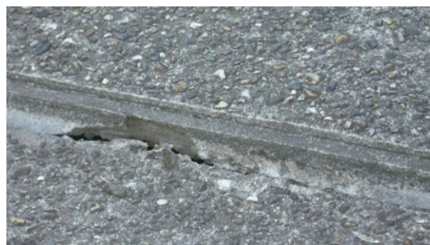
写真5 教育普及部前テラスが約5cm沈下(4月7日の余震でさらに沈下)。「美術館探検」で多くの子どもたち(10歳未満)が訪れる箇所の一つとな
