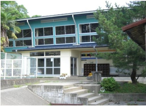
【避難所となった本校体育館】
