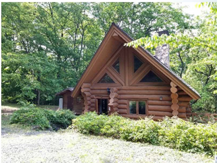
空き家を改修した宿泊施設
