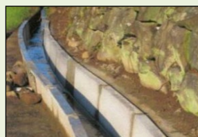
素堀り水路からの更新
