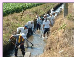
水路の泥上げ
