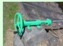
ゲート、バルブの更新
