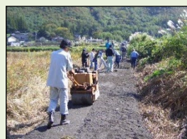
未舗装農道の舗装
