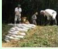
漏水箇所の補修
