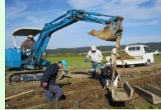
コンクリート水路の更新
