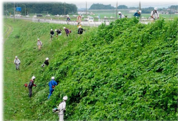
斜面の草刈作業
