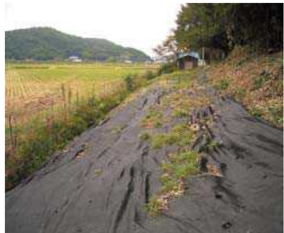
林縁部の斜面をシートで覆う
