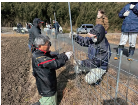
設置作業の様子
