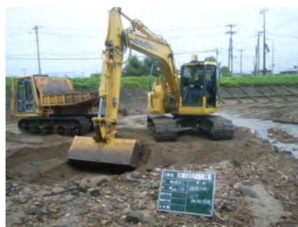
堆積土砂撤去
