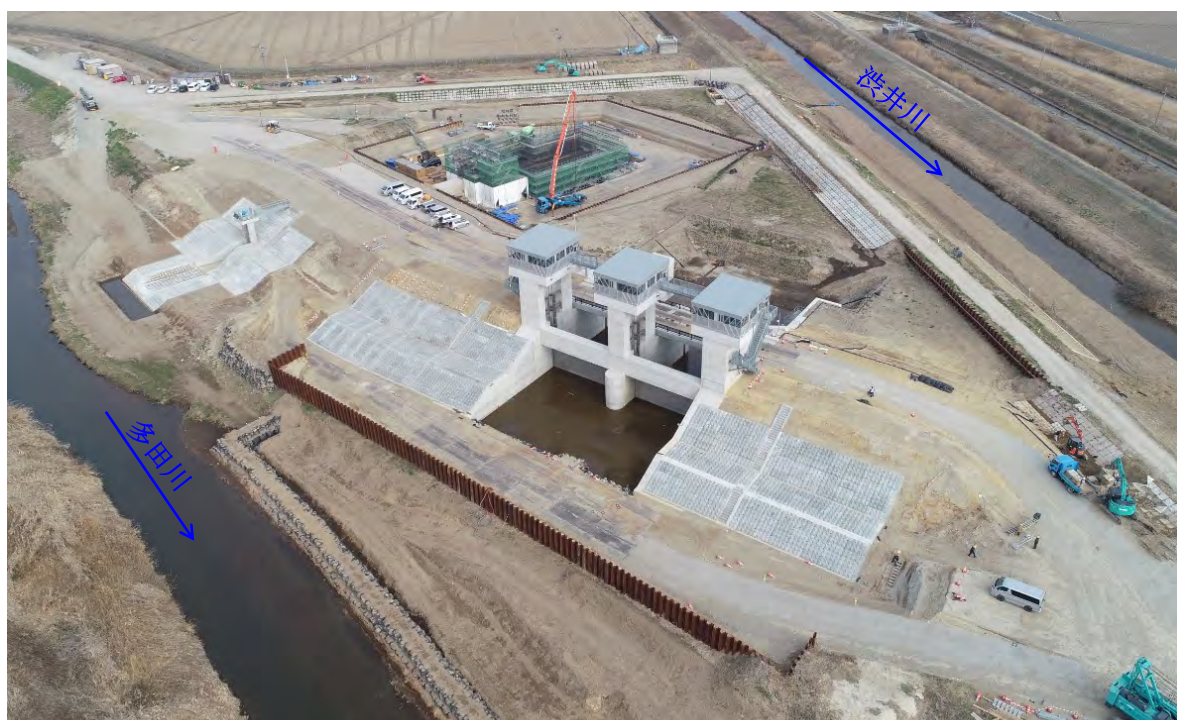
水門工事現況写真
