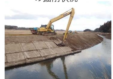
①範囲に盛土を行い築堤します。その後，②箇所を掘削して流下断面の確保を行います。
