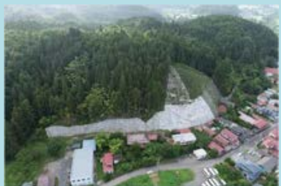
川口急傾斜地崩壊対策事業【継続中】
