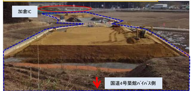
○ 地盤改良工が完了し、盛土工や橋梁下部工工事などを行っています。
