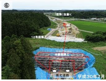
本線函渠工周辺の施工状況です。現在,本線函渠工の配筋が完了し,コンクリートの打設に向けて型枠工を施工中です。本線函渠工施工完了後,(仮称)加倉ICに向かって切土工事に入ります。
