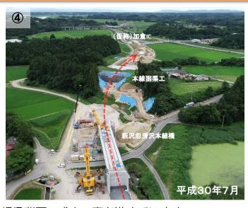
後沢本線橋の周辺では、現在道路本線に加えて、橋梁背面の盛土工事を進めています。 また、7月11日までに、萩沢忽滑沢本線橋の上部工を架設し、築館工区の4橋全ての上部工架 設が完了しました。今後は橋梁周辺の盛土工事を進めていきます。
