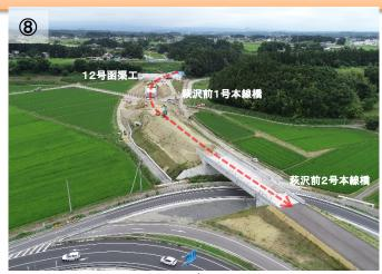
12号图渠工周辺の施工状況です。12号图渠工はコンクリートの打設が完了しており、後片付けを含めて8月には完成の予定です。12号图渠工~萩沢前2号本線橋の区間については、盛土工事を進めています。
