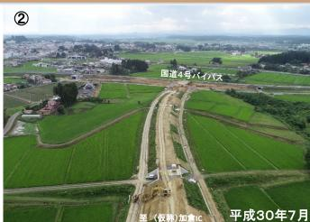
起点部4号バイパス接続部周辺です。みやぎ県北高速幹線道路では盛土工事と4号バイパスの拡幅工事を行っています。秋頃からの舗装工事着手予定です。
