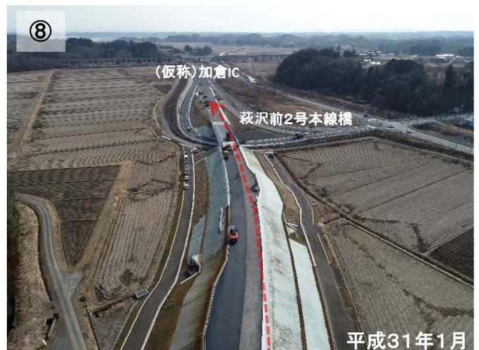
12号函渠工～萩沢前1号本線橋の区間については、軟弱地盤区間であることから、現在沈下状況を観測中です。沈下収束後、余盛土の掘削を行う予定です。萩沢前1号本線橋～(仮称)加倉ICの区間については、舗装工事を施工中です。
