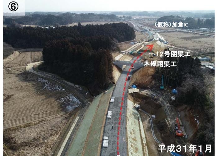
萩沢忽滑沢本線橋周辺の施工状況です。橋の西側については道路盛土を施工しており、2月中旬に盛土完了を予定しています。橋の東側については、道路盛土及び切土工事が完了しており、舗装工事及び排水工事を施工中です。
