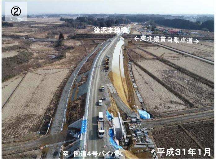
起点部4号バイパス接続部周辺です。国道4号バイパスの右折車線設置のための拡幅部分は、舗装工事が完了し道路照明・信号機も設置されました。みやぎ県北高速幹線道路部では舗装工、防草工や法面保護工などの付属施設を鋭意施工中です。
