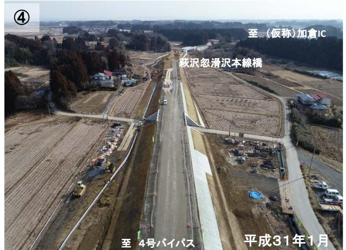
後沢本線橋周辺では、11月に橋台の背面盛土が完了し、後沢本線橋の東西が繋がりました。道路盛土については、萩沢忽滑沢本線橋周辺を残して完了しており、盛土が完了した区間については舗装工、防草工や法面保護工などを施工中です。
