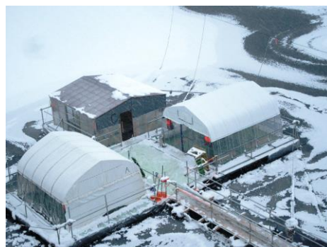
(ドーム船全景)
