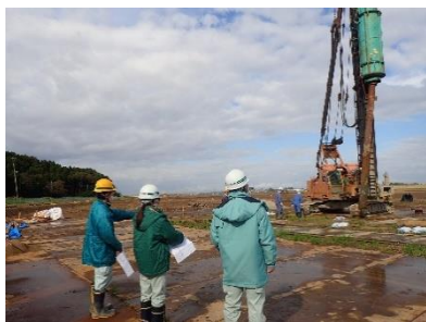
◀杭打機による打設状況
