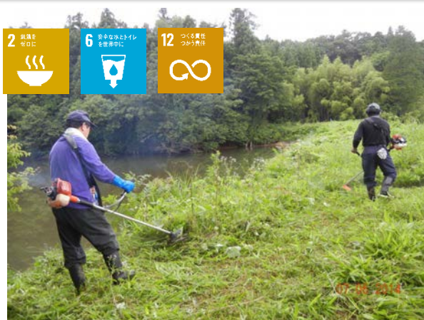
ため池堤体の草刈り
