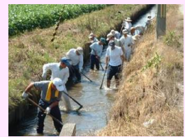
水路の泥上げ
