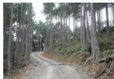
森林作業道の開設
