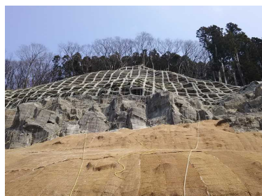
復旧治山事業（既設 中道）
