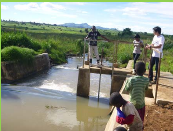
協力隊活動（取水施設の管理状況確認）
