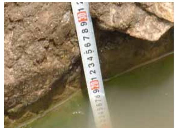
写真7, 8 : 取水工の堆砂（堰本体は安定しているが、堆砂が進行している）
