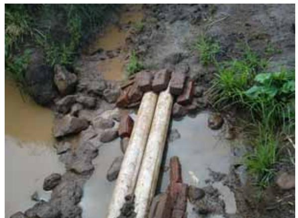
写真 39, 40 : 降雨後の洗掘の状況
