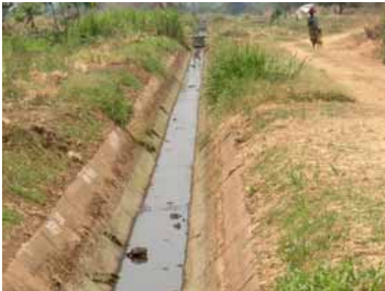
写真3：幹線水路の状況
