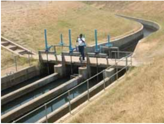
写真1：取水路直下流の沈砂地
