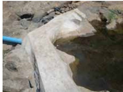
写真5：コンクリート堰（事例）
