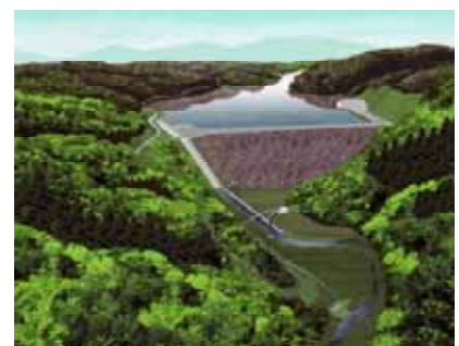
ニツ石ダム(鳴瀬川水系・造成中)
