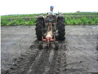
除塩実証試験:暗渠設置(名取市)
