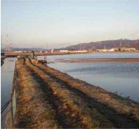
被災後(平成23年3月)
