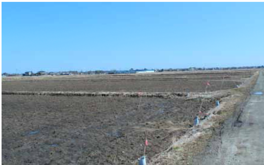
農地復旧後(平成24年3月14日)
