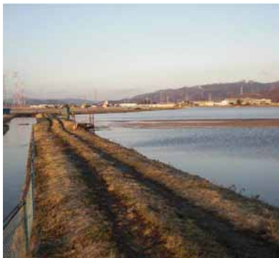
被災後(平成23年3月)
