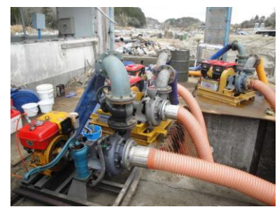
被災した排水機場への応急ポンプ設置(東松島市)
