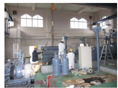
被災した排水機場の応急復旧(東松島市)
