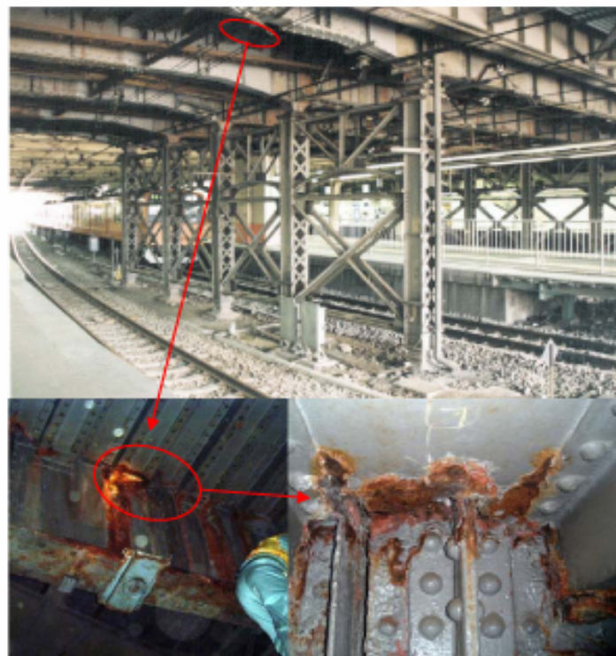
※新宿駅南口地区基盤整備事業の一環として、架替工事中
