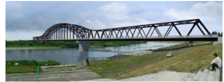
幹線道路整備(国)113号館矢間バイパス
