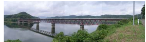
耐震補強(国)286号釜房大橋
