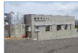
蔵王トイレ再整備 (駒草平)
