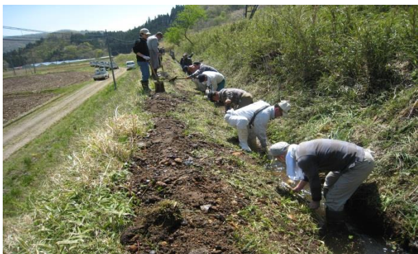
【水路の泥上げ】
