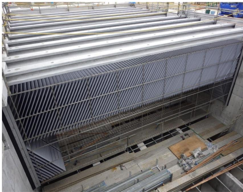
施工状況 (①) : 沈殿池傾斜板設置状況
