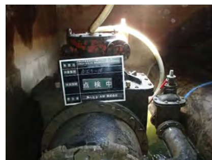
制水弁点検状況
