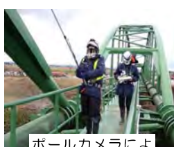
ポールカメラによる 近接目視点検
