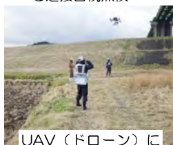
UAV（ドローン）による 近接目視点検
