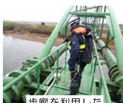
歩廊を利用した 近接目視点検
