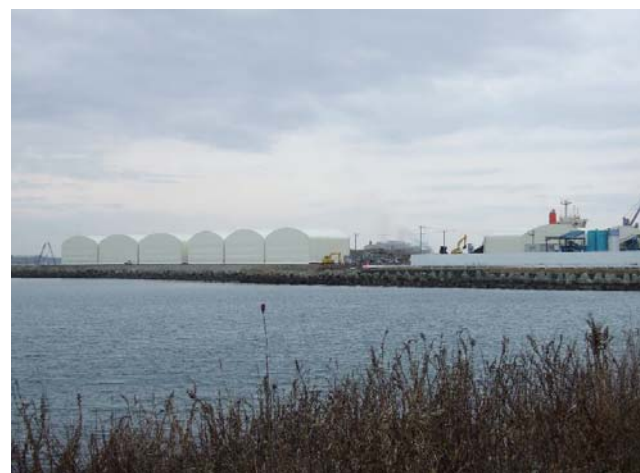
⑥埋立材(焼却灰造粒固化後)ストックヤード(白テント)
