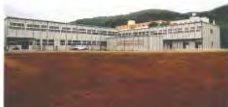
宮城県農業高等学校仮設校舎
