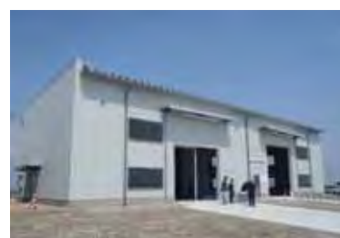
開設した開上仮設魚市場
