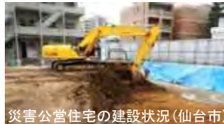
災害公営住宅の建設状況(仙台市)
