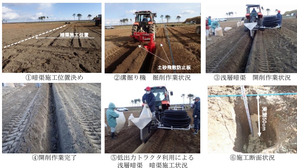
図1 低出力トラクタを利用した浅層暗渠の施工方法
