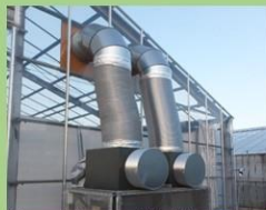
施設内部への外気導入による 効果的な昇温抑制方法の検証
