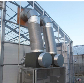
図3 外気導入用試作ファン
