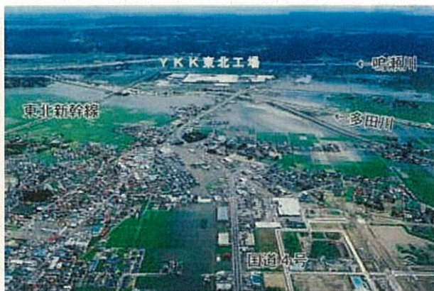
洪水被害状況 (大崎市三本木) H14. 7. 11
