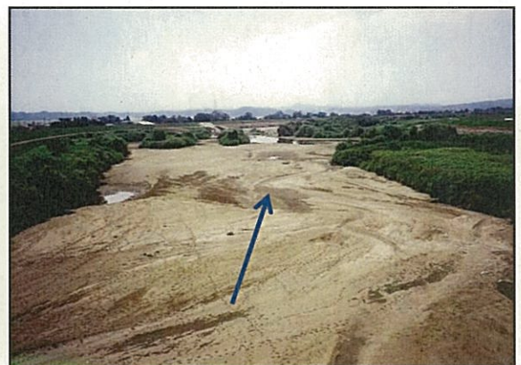
ほとんど水が流れていない鳴瀬川 (大崎市鹿島台木間塚) H6. 8. 8
