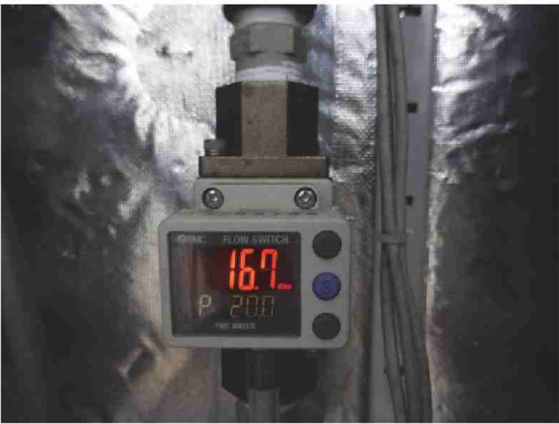
⑪RO 水製造量(@0.65 MPa) 16.7 L/min
