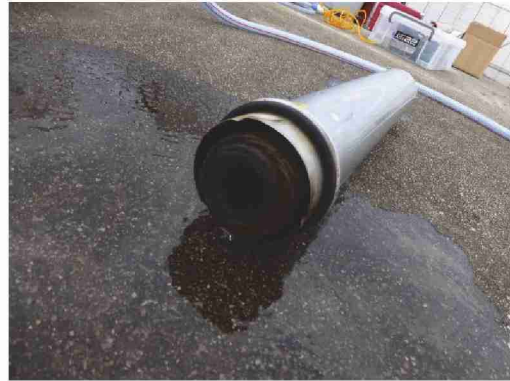
⑧保安フィルターを交換する。
