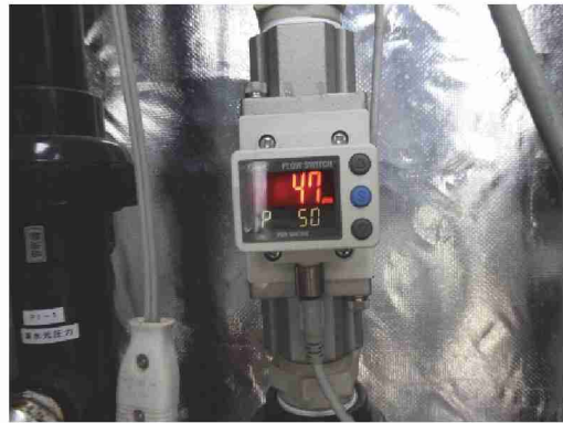
⑩RO 装置の圧力および流量を調整 供給水量 45-50 L/min
