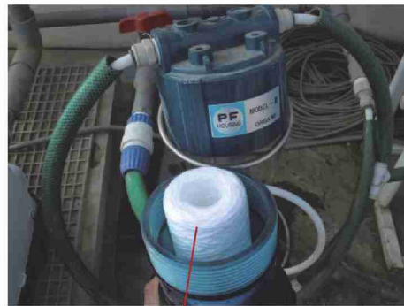
④新品のフィルターを入れて元に戻す
