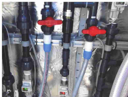
②薬洗用供給水口(左)、RO 水口(左)に配管
