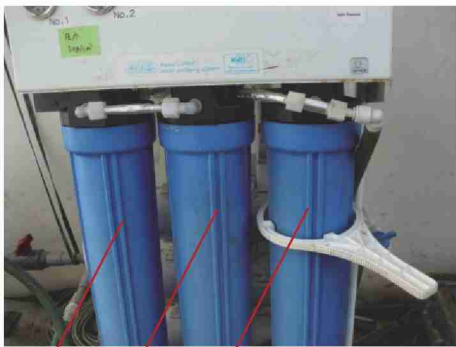
①1 \mu m、活性炭、5 \mu m フィルターのケースを外す
