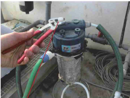
①エア抜きを回して取り外す
