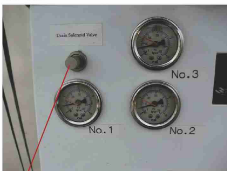
①圧カツマミを左に回しきり、最低圧力にする （0.25 MPa (2.5 kgf/cm 2 ) 程度になる）
