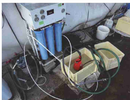
実証試験での薬品洗浄の様子
