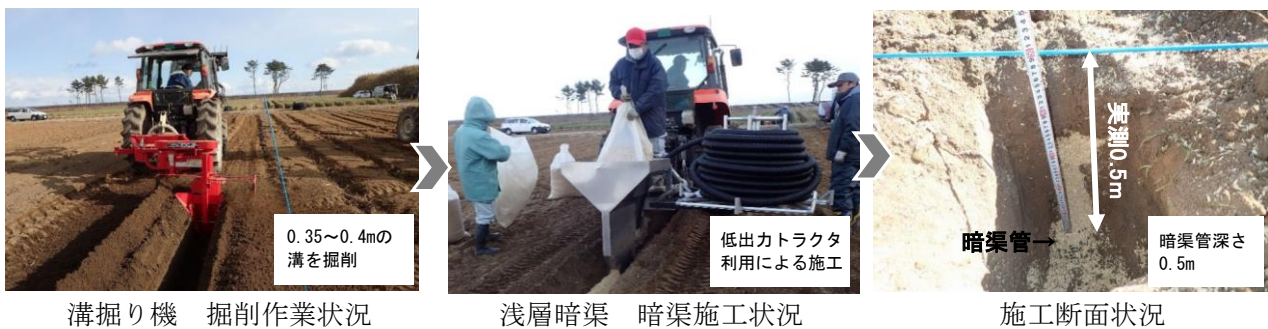
図1 低出力トラクタを利用した浅層暗渠の施工方法(一部抜粋)
